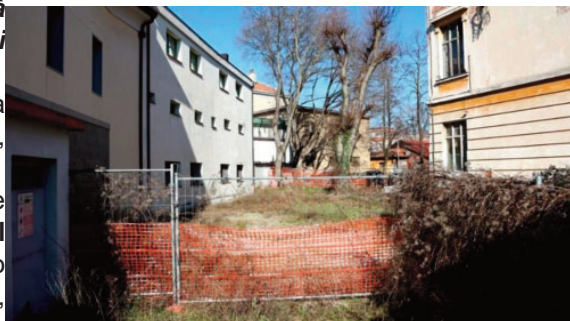
Il lavori di ampliamento della casa circondariale alla vicina ex scuola "Pitteri" in fase di stallo
